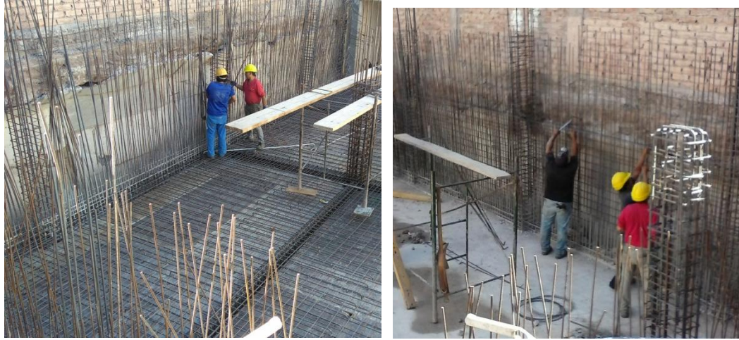
Figura 23: Tabique lateral en proceso de armado.
