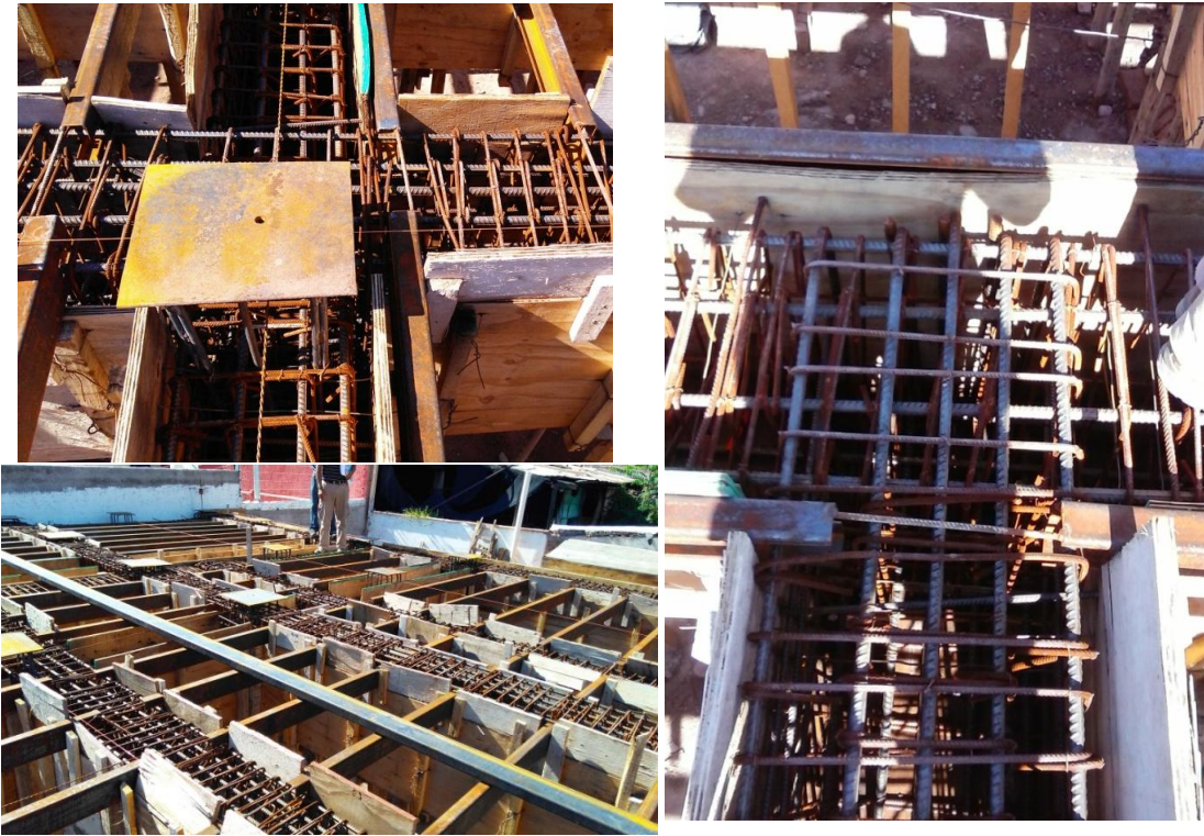
Figura 27: Vigas y arranque de columnas, bloque trasero
