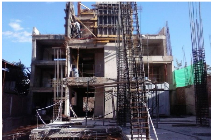
Figura 19: Vista general de la obra
