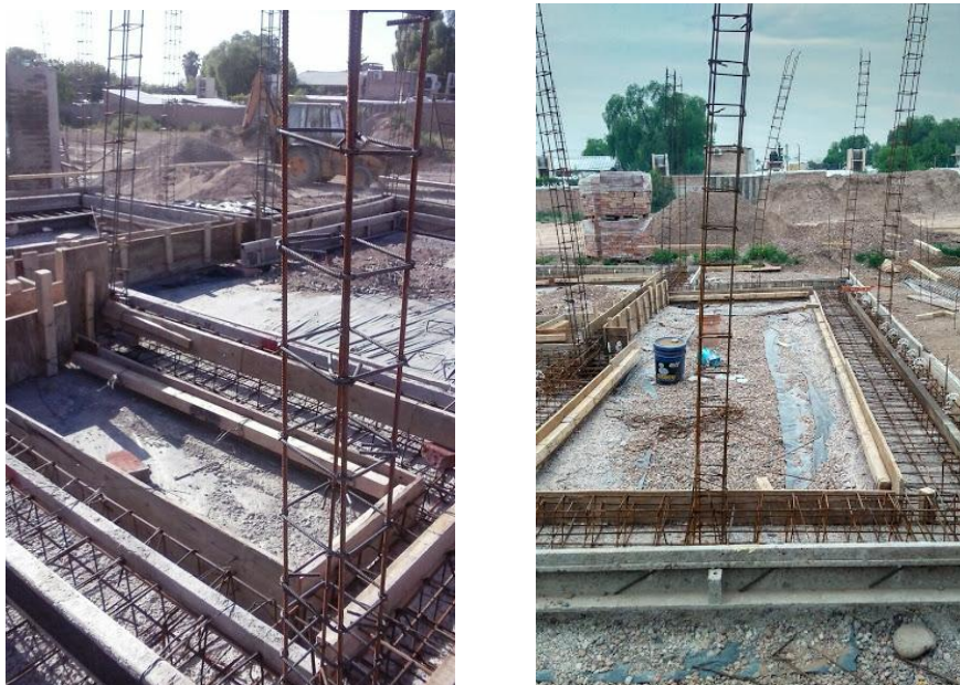
Figura 30: Arranque de columnas
