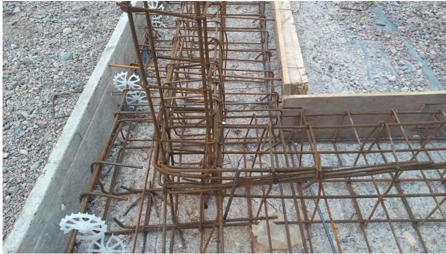
Figura 31: Arranque de columnas
