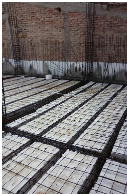
Figura 22: losa alivianada perteneciente al segundo subsuelo.
