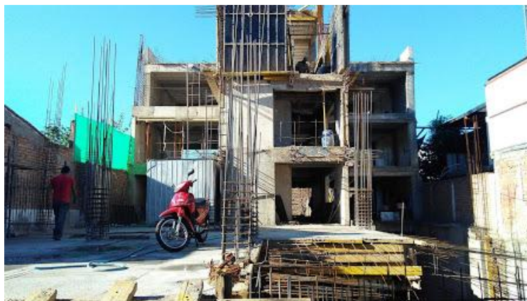
Figura 25: Avance de obra hasta el nivel del segundo subsuelo
