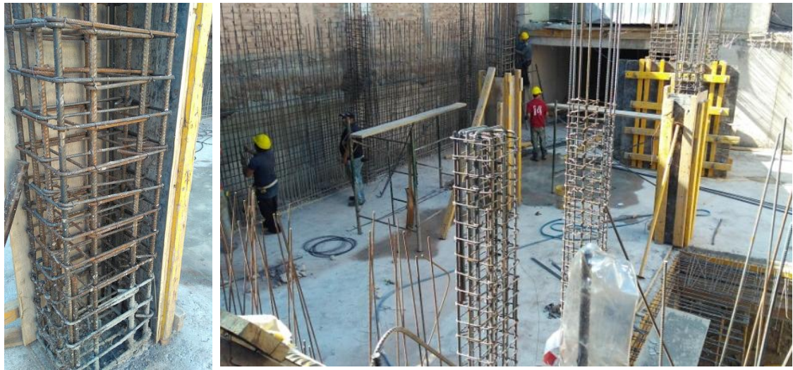
Figura 24: armado de columnas.
