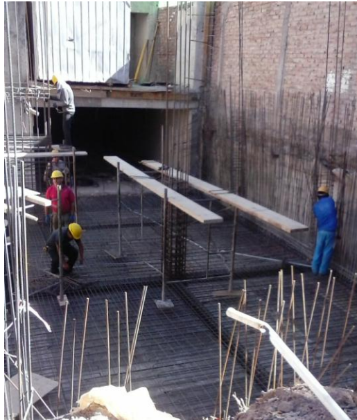
Figura 21: losa maciza perteneciente al primer subsuelo.
