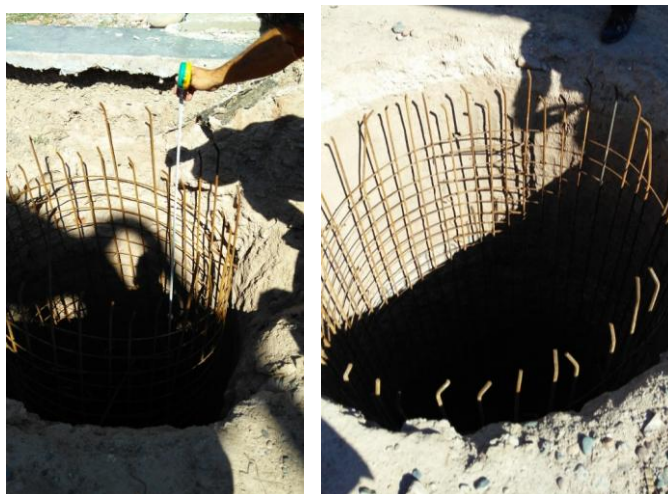
Figura 26: Pozos de fundación bloque delantero
