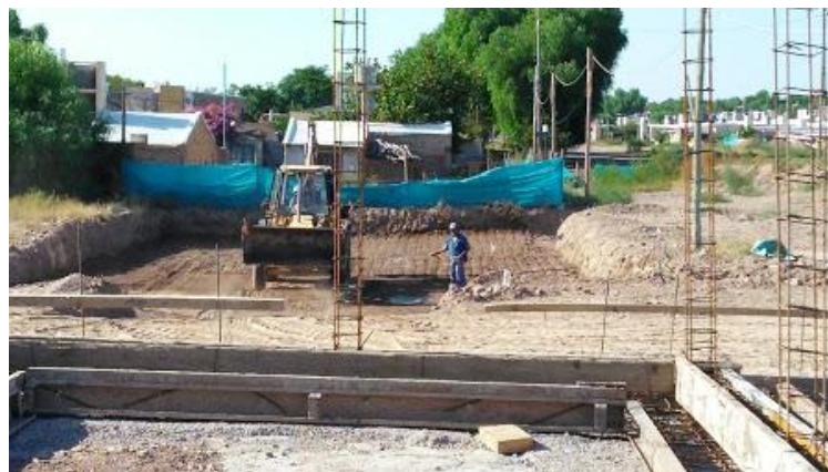
Figura 28: Proceso de compactación de suelo
