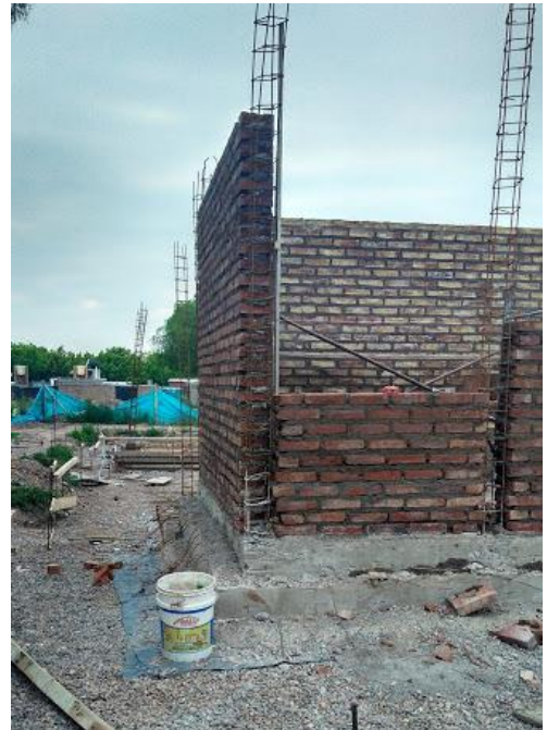
Figura 32: avance de obra hasta el nivel de vigas de techo
