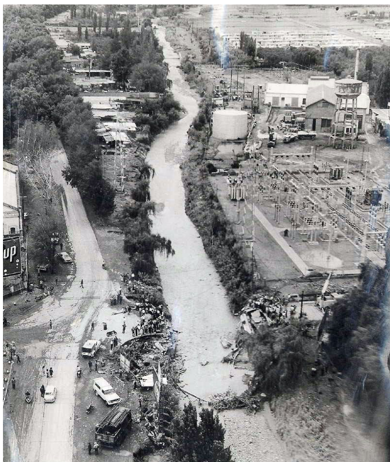
Dique Frías colapsó y abrió caminos
