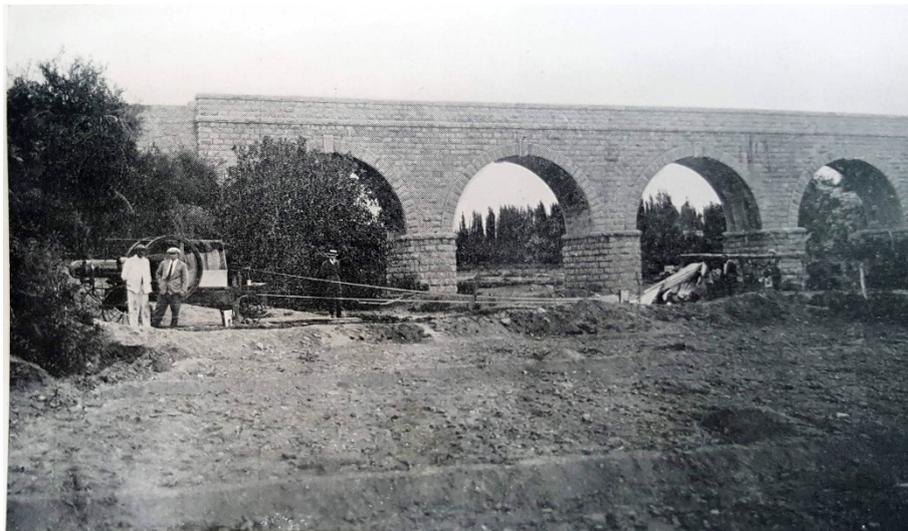
Figura 31. Acueducto sobre el río Las Chacras y obras de construcción. Fotografía por J. La Vía. En Gez, J. W. (1939b).
