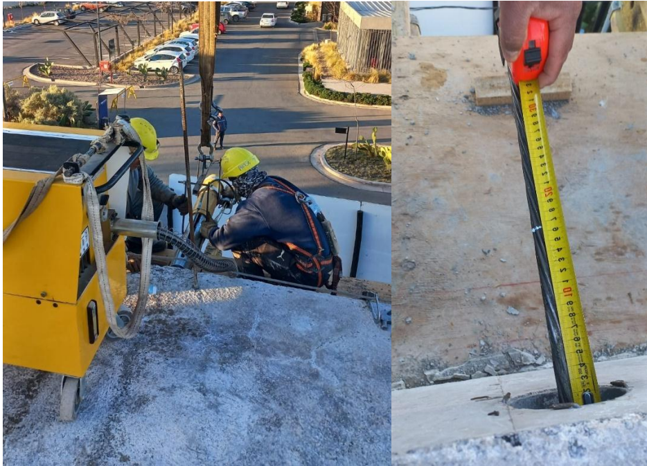
Fig. 39: Tensado del cable mediante un gato hidráulico y verificación de la long. de deformación
