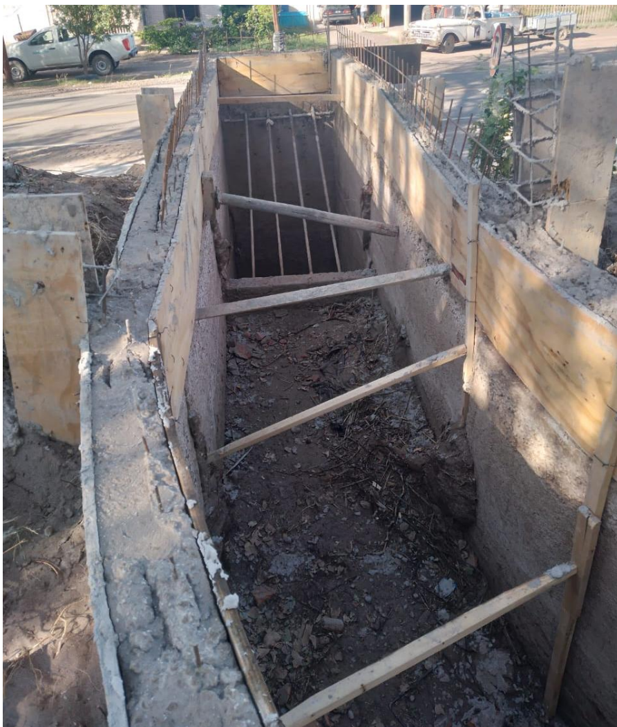
Figura 25. Obra casi concluida sobre el sifón
