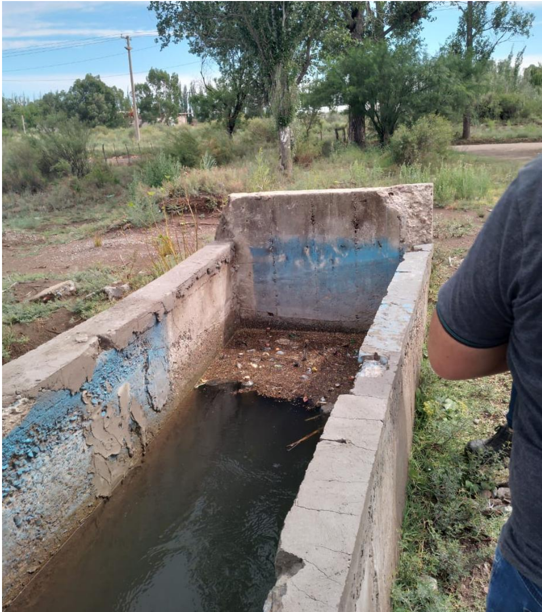
Figura 20. Salida del agua del sifón
