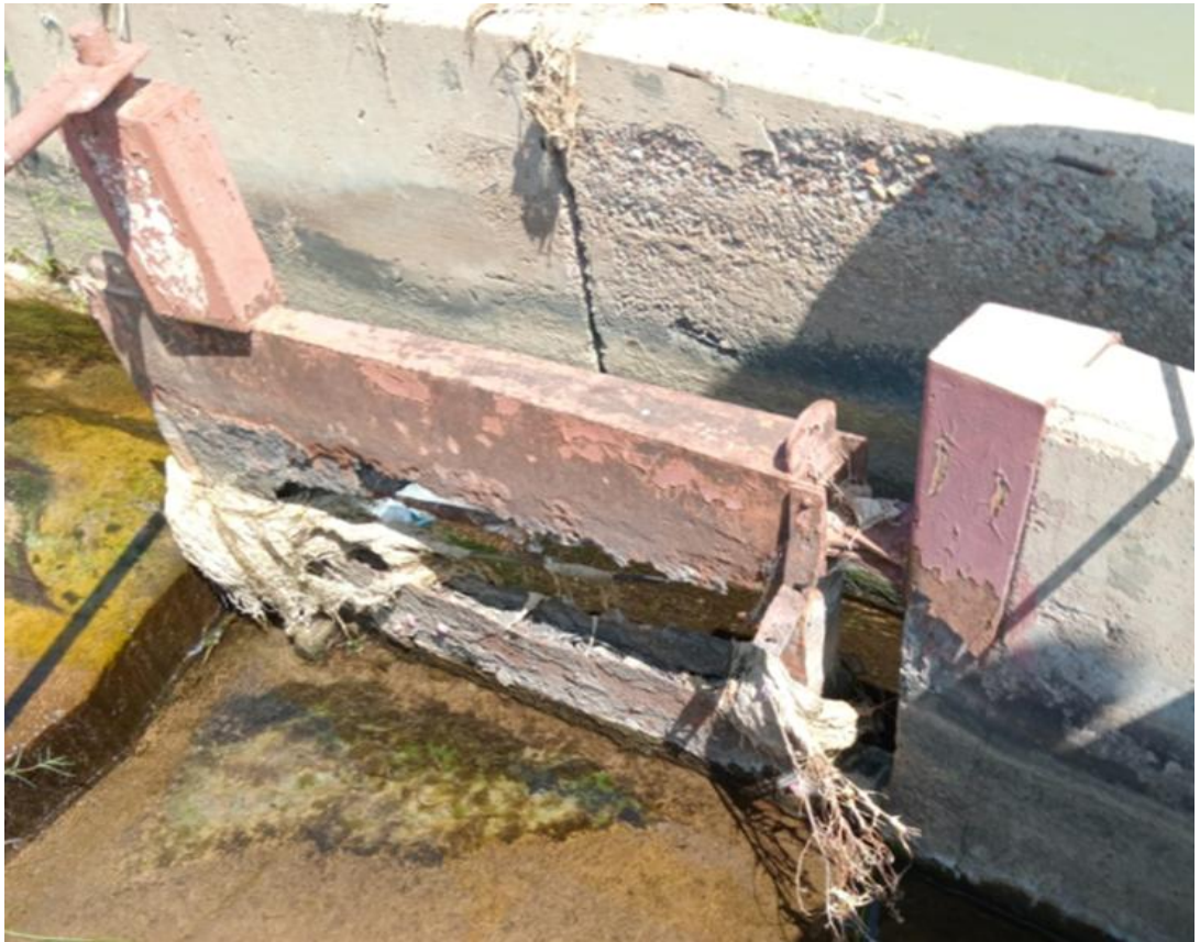
Figura 5. Vista del partidor móvil actual en el compartó Rio Bamba Viejo
