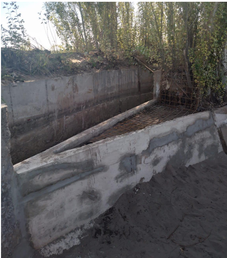
Figura 26. Obra de reparación sobre el canal secundario
