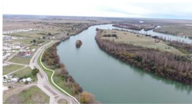
Figura 9.3. Vista aérea del canal de Pomona.
