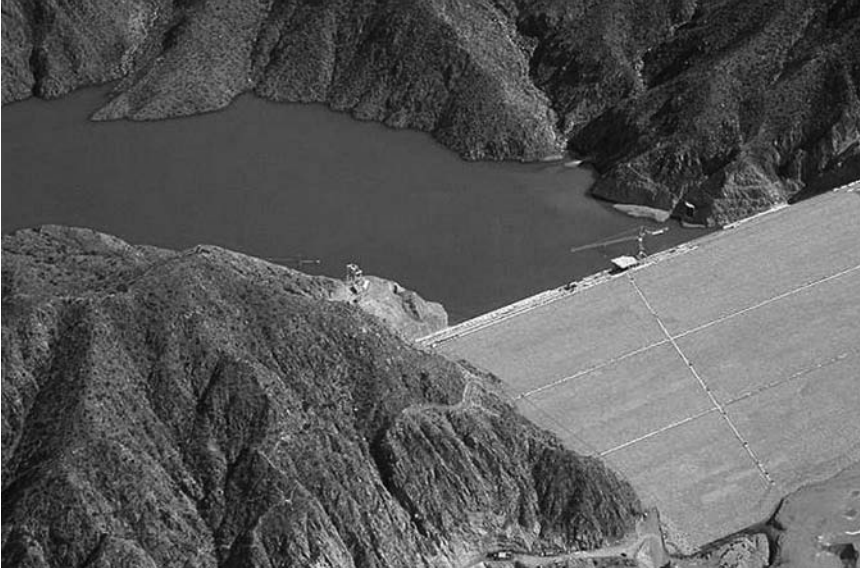
Imagen del Dique Potrerillos durante su construcción
