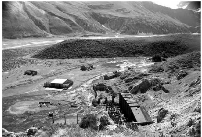
Planta de concentración de azufre SOMINAR. El Río Atuel circula entre el promontorio y el macizo que se encuentra en el fondo.
