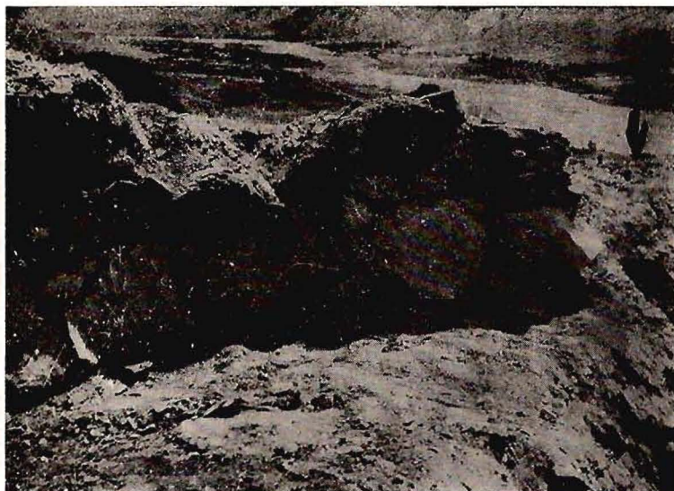
El tipo más común de pirca es el que presenta una primera hilada de piedras grandes y luego continúan rodados y lajas pequeñas.
