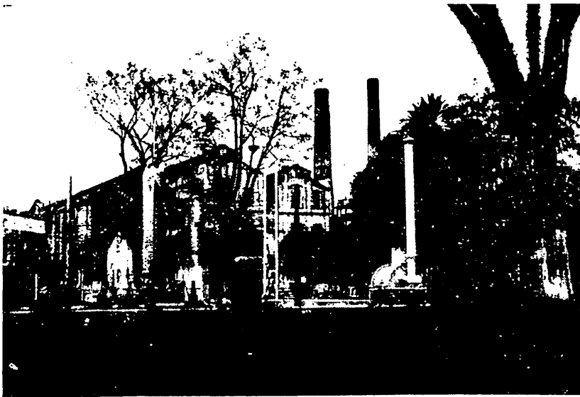
Fot. 4 — Vista del frente del ingenio San Pablo, fábrica situada a pocos kilómetros de la ciudad de San Miguel de Tucumán. En primer plano, las instalaciones para provisión de gas natural, combustible utilizado hoy en la mayor parte de los ingenios.
